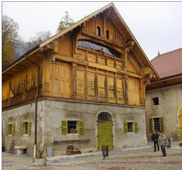
Quelques agriculteurs de la région ont pu visiter le bâtiment principal. Photo Le DL/G.B.
